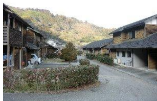
初の福川町営住宅（木造）
