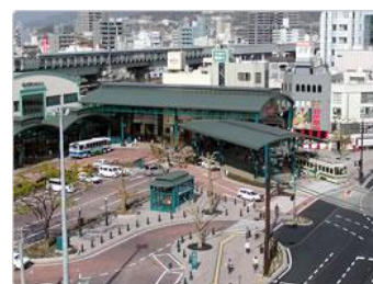
駅広内に移設された横川電停
