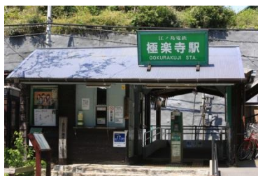
レトロなトタン葺き屋根の極楽寺駅
