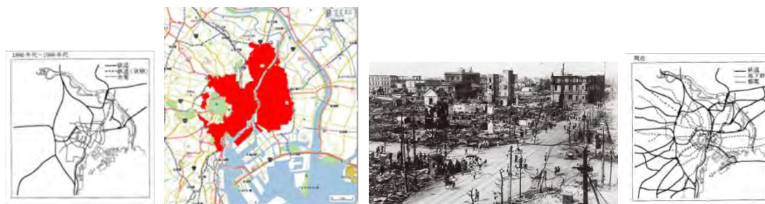
関東大震災の被災区域と災害状況また震災前後の鉄道整備の進展状況
