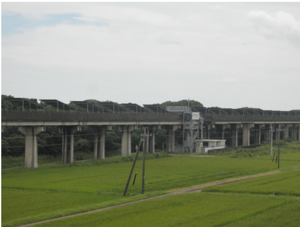
「リニア実験線跡の高架上に設置されたメガソーラー設備」
