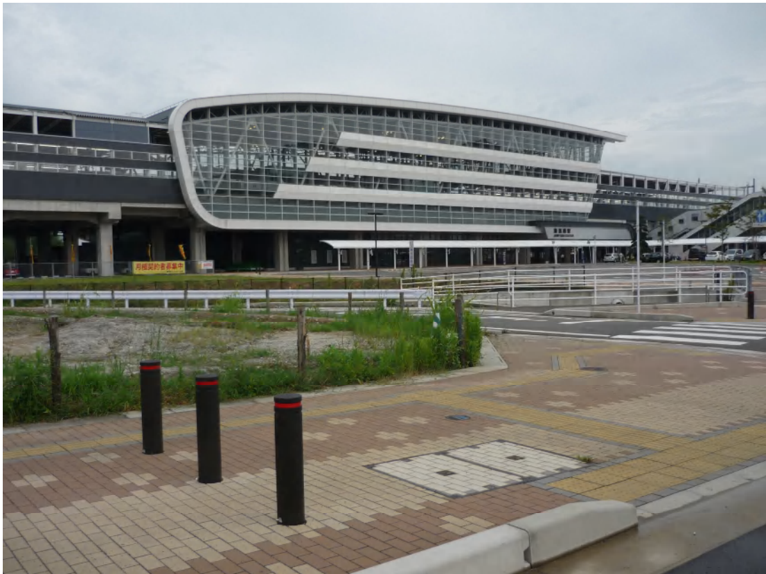
「九州新幹線新鳥栖駅。既に開業している。」
