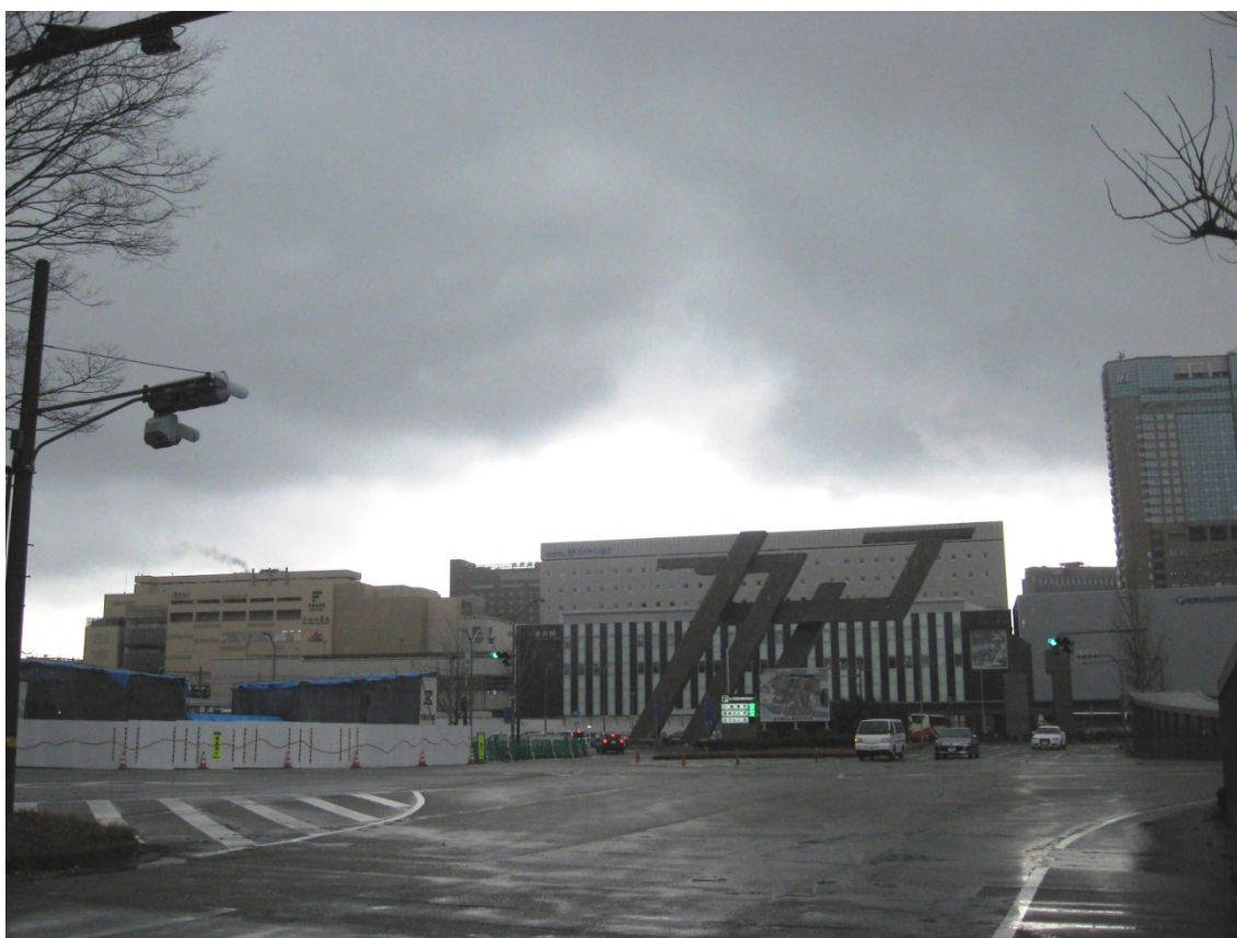
「新幹線開業に向けて整備工事が進む金沢駅」
