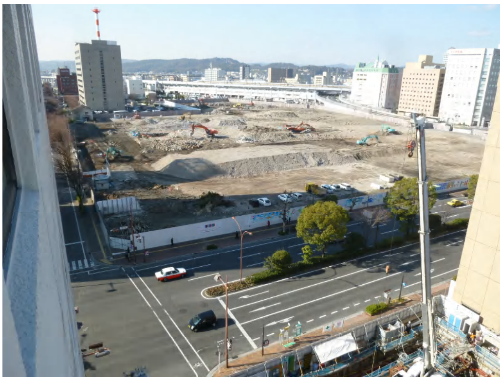
「基礎工事段階に入ったイオンモール」
