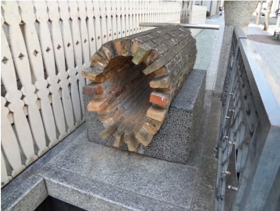
「旧居留地の煉瓦造り下水道」
