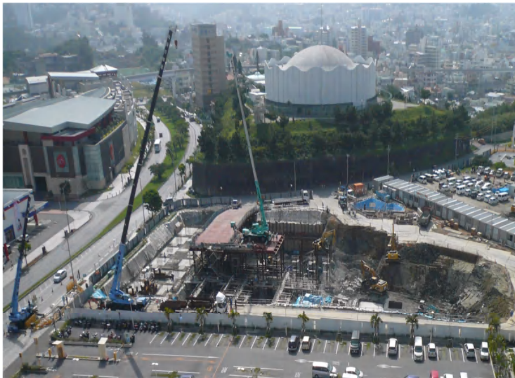
「那覇新都心地区で建設中の高層ビル（平成22(’10)年3月撮影）」
