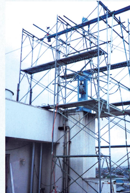
煙突上部及び灰出し口を隔離養生
