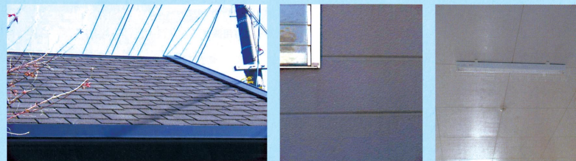
石綿含有住宅化粧用スレート（屋根）
