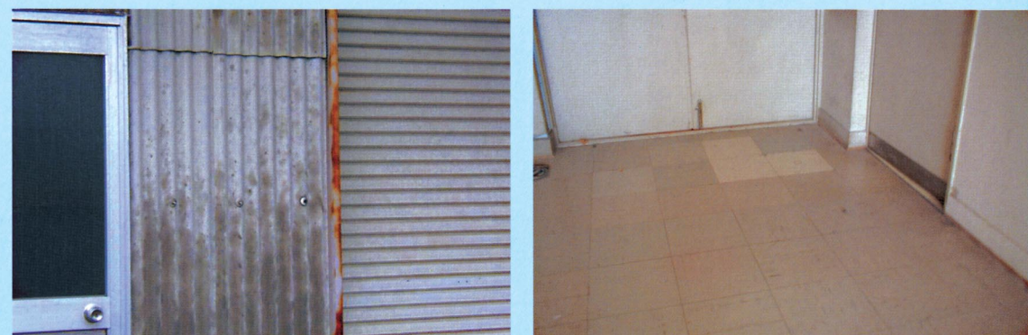
石綿スレート（屋根・外壁）
