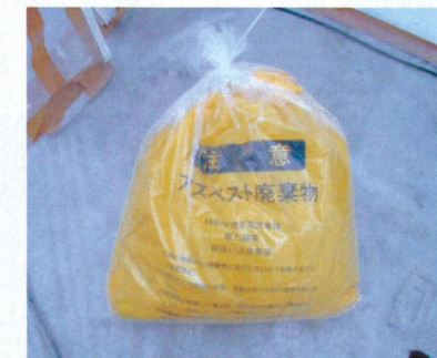
アスベスト廃棄物の二重袋詰
