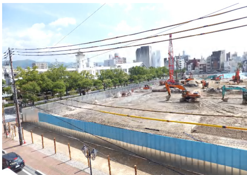
「新図書館の建設工事現場」
