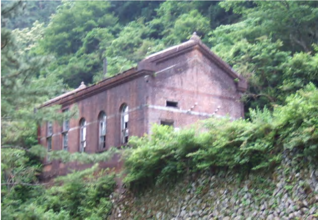
「第三変電所跡」
