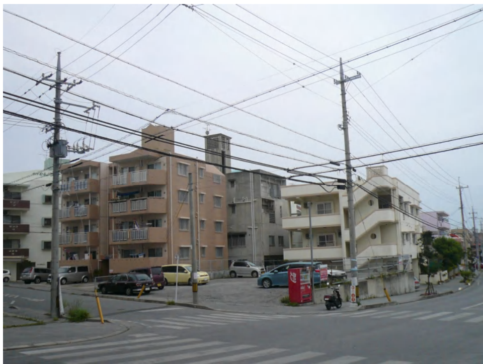
「沖縄のアパートは鉄筋コンクリート造り 3～4階建てで、エレベーター無しが標準的」
