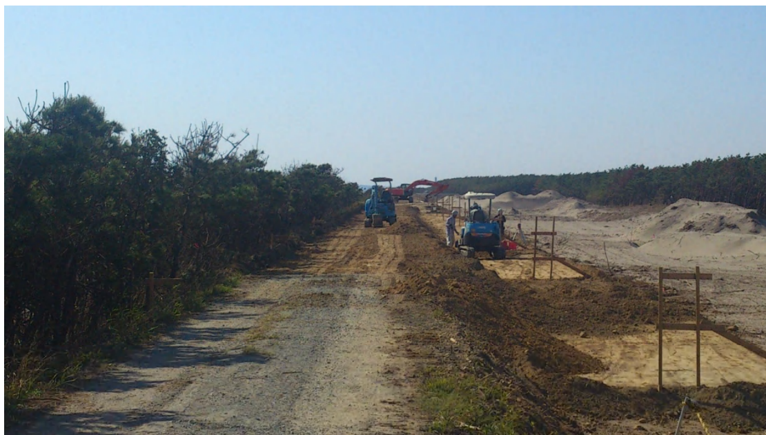
防潮堤整備工事の現場
