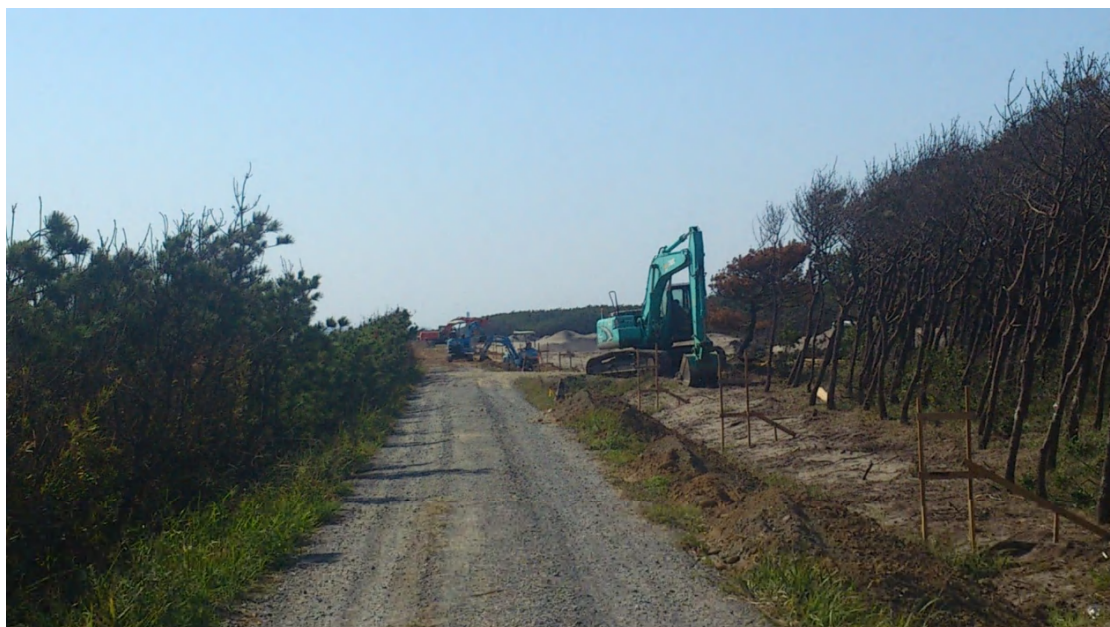
防潮堤整備工事の現場
