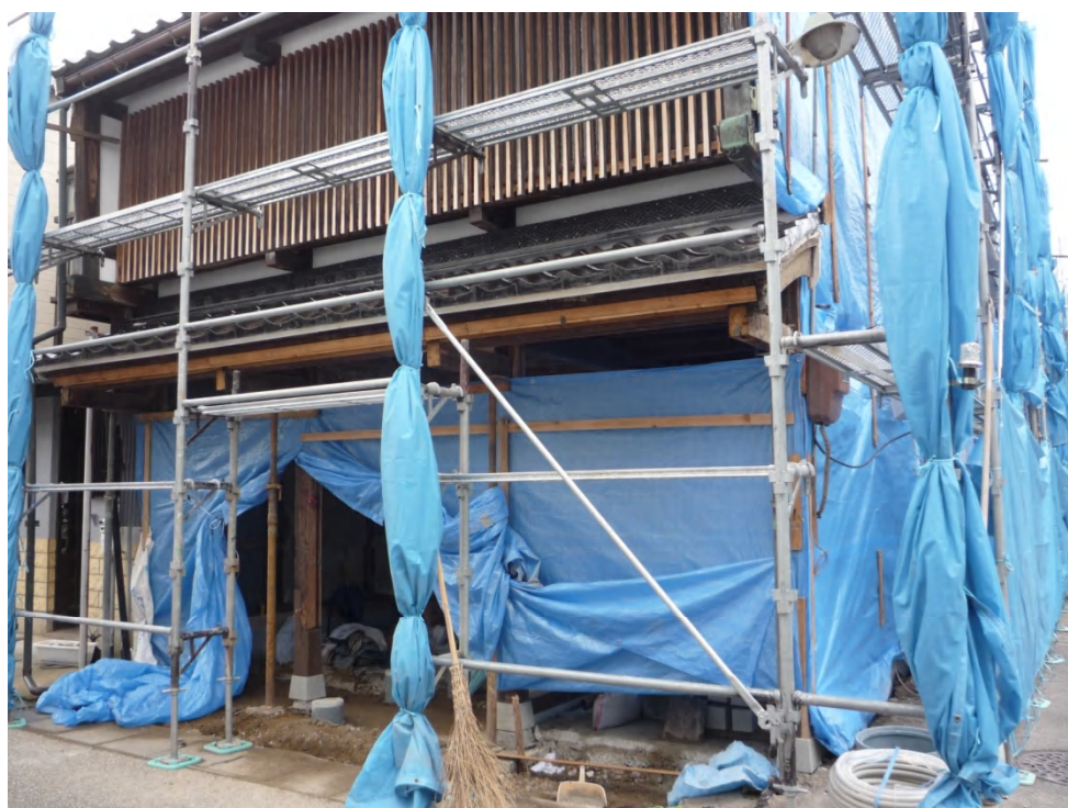
現在も官民一体となった工事が進められている
