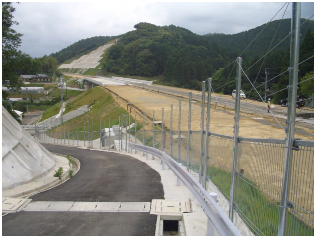
「着々と工事が進む東九州自動車道」
