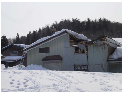
「雪の重みで倒壊した住宅」
