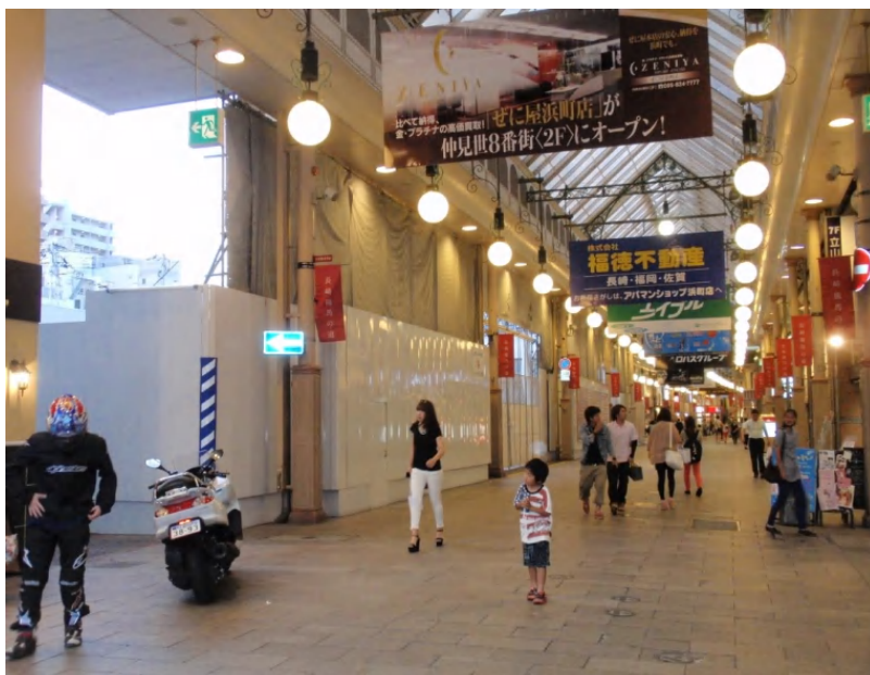
「浜町アーケード街の旧博多大丸長崎店の跡地では新ビルが建設中」
