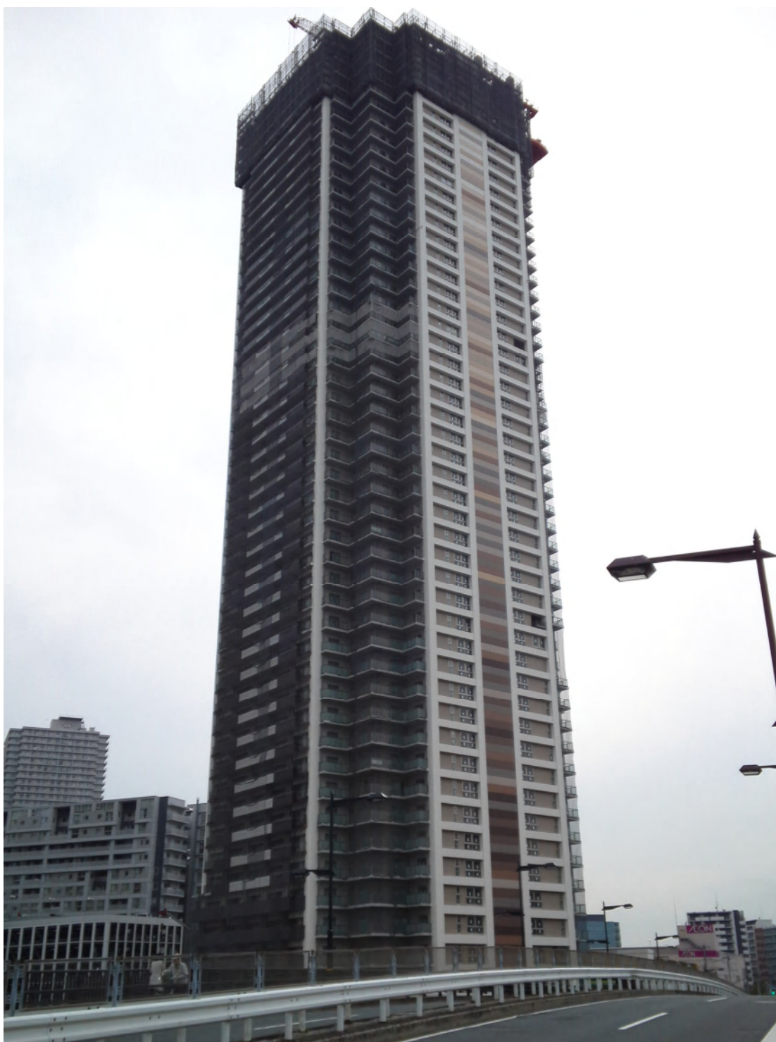
「建設中の『プラウドタワー東雲キャナルコート』(江東区東雲)」
