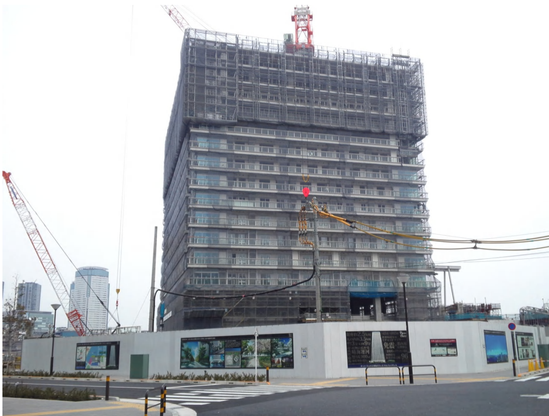
「建設中の『ザ・パークハウス 晴海タワーズ クロノレジデンス』(中央区晴海)」
