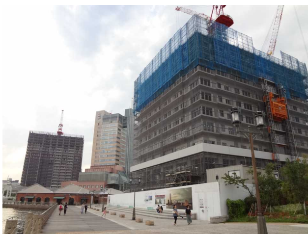
「建設が進むタワーマンション」
