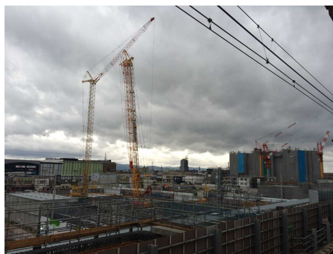
「マンションの建設現場」
