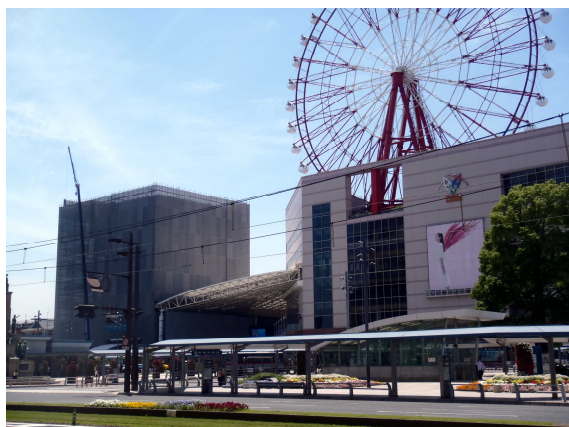
「アミュプラザ鹿児島 別館」の建設工事が進行する鹿児島中央駅前
