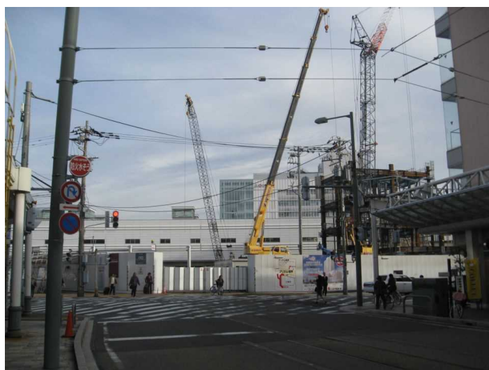
「建築工事が進む福井駅西口再開発ビル」
