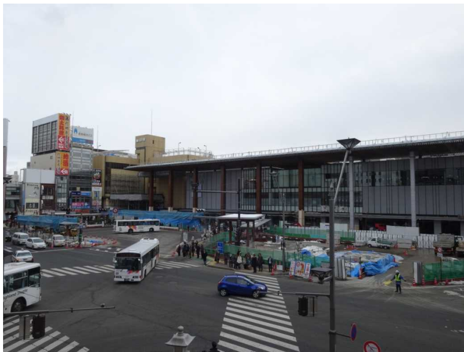
「新幹線延伸開業に向け整備が進む新駅ビルと駅前広場」
