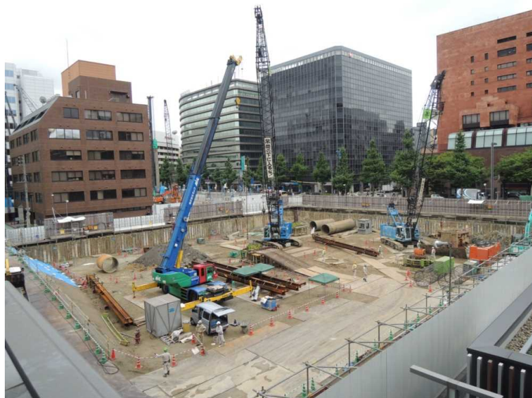
「再開発が進む JR博多駅前の博多郵便局跡地」
