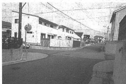
③ 完成した定住促進住宅団地の街並み
