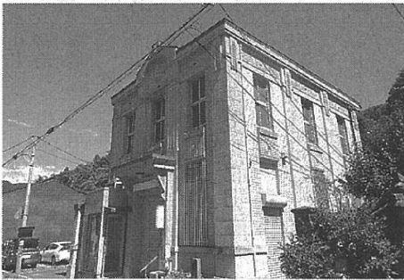
繁栄を偲ぼせる寄棟洋風建築の山陰合同銀行旧根雨支店
