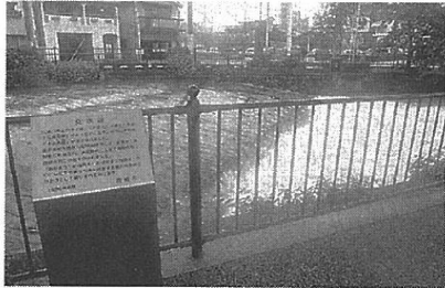
今も残る製糸工場に水を引き入れるための「交水堰」
