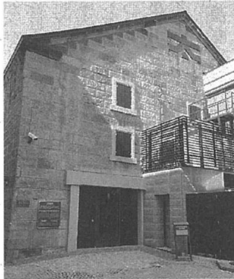
旧高橋倉庫の建物を活用して出来たスタンドグラス美術館
