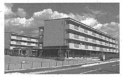
志津川東地区災害公営住宅
