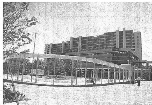
ZUTTO CITY。駅ビルとバス停整備で住民の利便性は向上した
