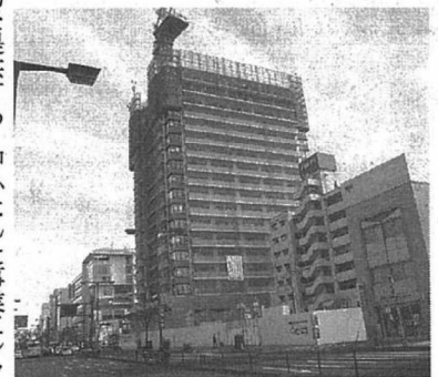
建設が進む「宇都宮大手地区第一種市街地再開発事業」
