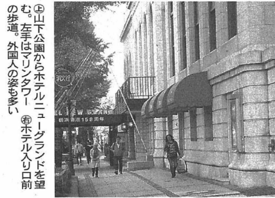
④山下公園からホテルニューグランドを望む。左手はマリントワー ⑤ホテル入り口前の歩道。外国人の姿も多い
