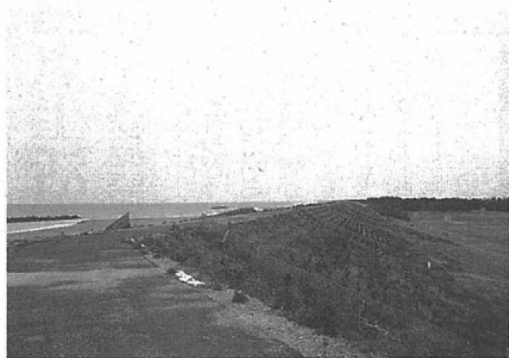
高さ約15m、全長約17.5kmに及ぶ防潮堤
