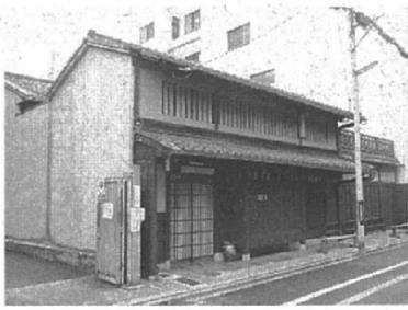
マッチング制度で文化体験施設として活用される京町家
