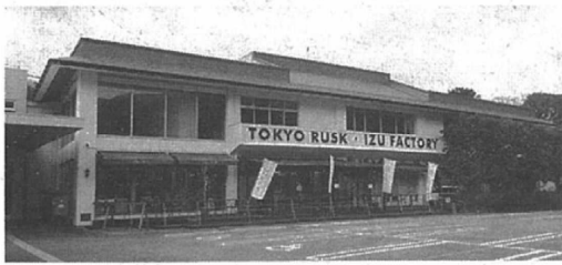
菓子メーカーの直売工場となった旧天城湯ヶ島町役場庁舎
