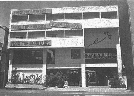
改修棟(ヘリテージタワー)
